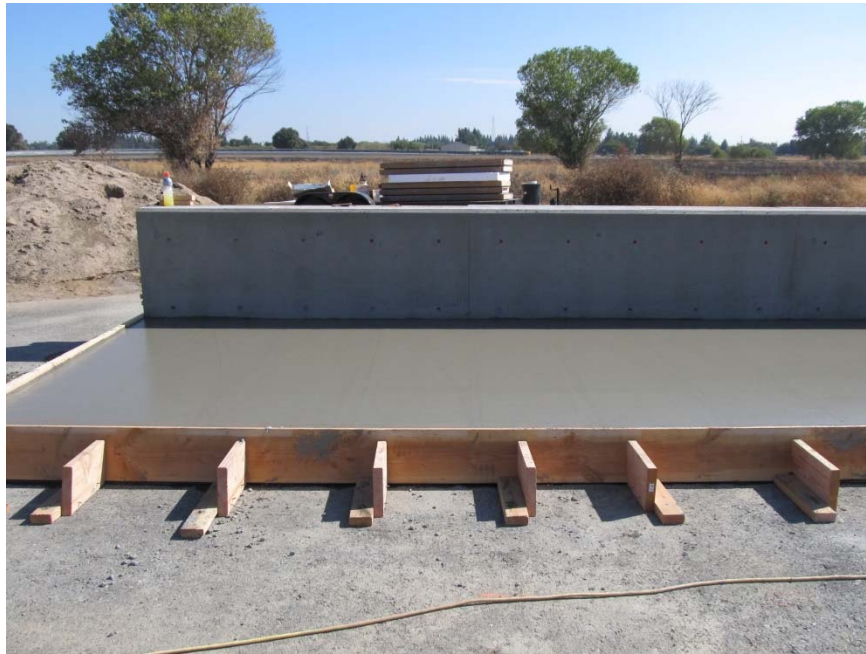
Figure 2-5 – Type 732SW after sidewalk pour
